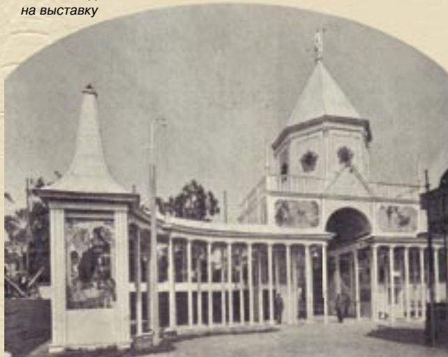
Главный вход на выставку
