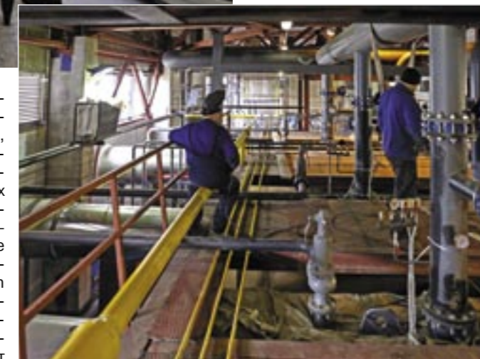
Монтаж оборудования энергоблока на площадке строительства
