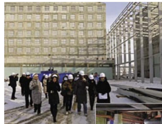
Экскурсия на строительную площадку конгрессно-выставочного центра «ЭкспоФорум» для организаторов мероприятий в новом комплексе
